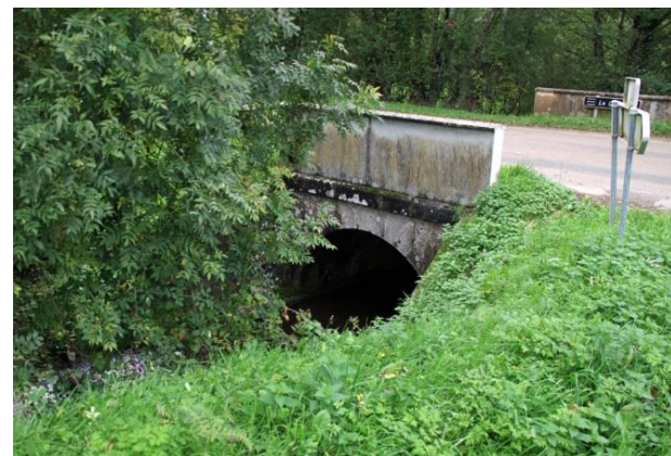
Photo 11 : pont sur le Chilleau (RD121 X RD176)
