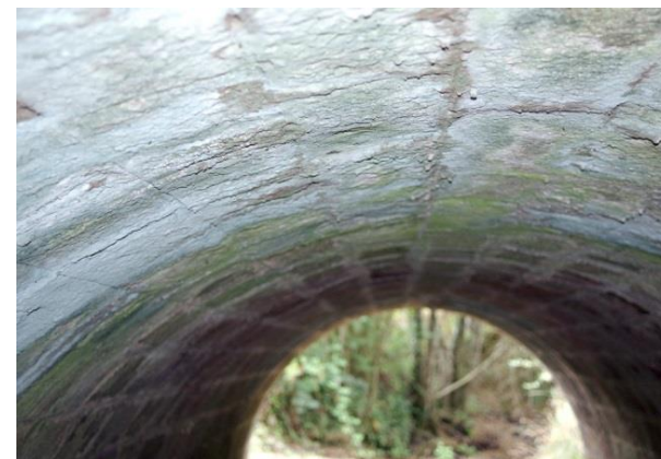
Photo 12 : inspection du tablier
