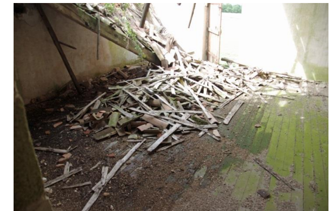
Photo 6 : état de la toiture
